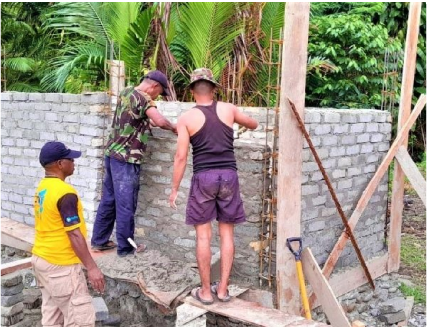
Satgas TMMD Saat Membuat Bak Penampungan Air Bersih Yntyk Warga Kampung Muara Nawa
